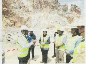
Sivanesan (biri) meninjau lokasi kejadian runtutan batu kapur yang menimpa pekerja kuari di Kemant Pulu dekat Simpang Pulai pada Jumaat.
