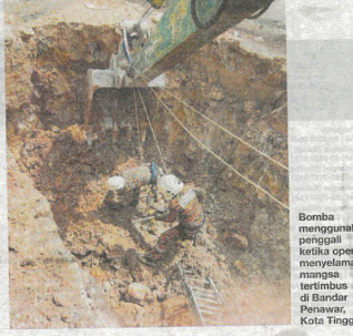
Bomba menggunakan penggali ketika operasi menyelamat mangsa tertimbus di Bandar Penawar, Kota Tinggi.
