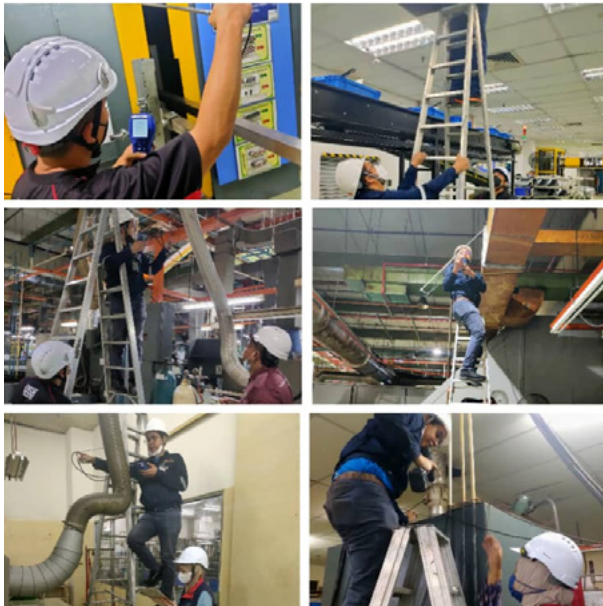
Aktiviti pemeriksaan LEV di Hitachi Bandar Baru Bangi, Selangor. LEV inspection activity at Hitachi Bandar Baru Bangi, Selangor.
