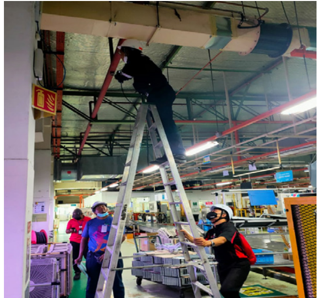
Aktiviti pemeriksaan LEV di Hitachi Bandar Baru Bangi, Selangor. LEV inspection activity at Hitachi Bandar Baru Bangi, Selangor.
